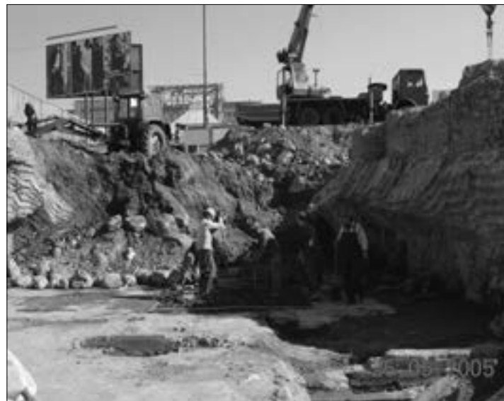
Рис. 5. Раскопки северной части подвала западного флигеля. 2005 год. Фото С. А. Коваль
