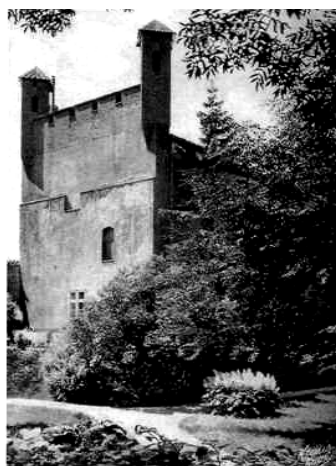
Рис. 5. Фронтон главного флигеля замка Шаакен с угловыми башенками, надстроенными в XIX веке в неоготическом стиле. Фотография. 1993 год
