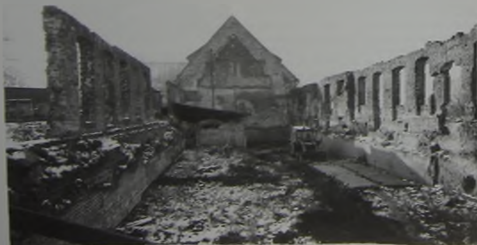
Abb. 9. Innenansicht des Wirtschaftsgebäudes (Bräutereiabteilung) nach Ausgrabung 1994 der Erdkammer. Fot. T. Okonka.
