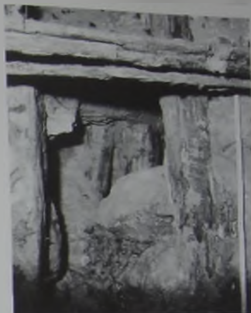
Abb. 5 Der Pfahlrost 1990 unterm Fundamentenfuß der Westwand. Fot. L. Olawski
