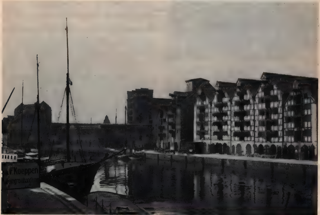
Fachwerkspeicher auf der Lastadie
