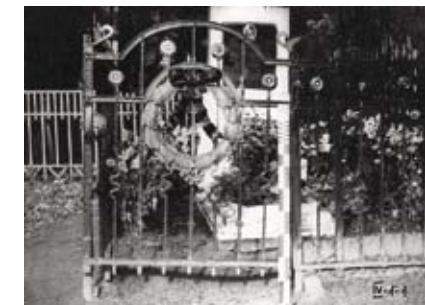
Vertingų elementų fotofiksacija miesto kapinėse, atlikta 1981 m. pagal LTSR kultūros ministerijos užsakymą. MLIM.
