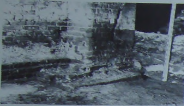
Abb. 11. Pfeilerfundament mit gewisser Korrektur seines Standes, daneben rechts die durchgeschrittenen Bodenschichten. Foto Verfasser.
