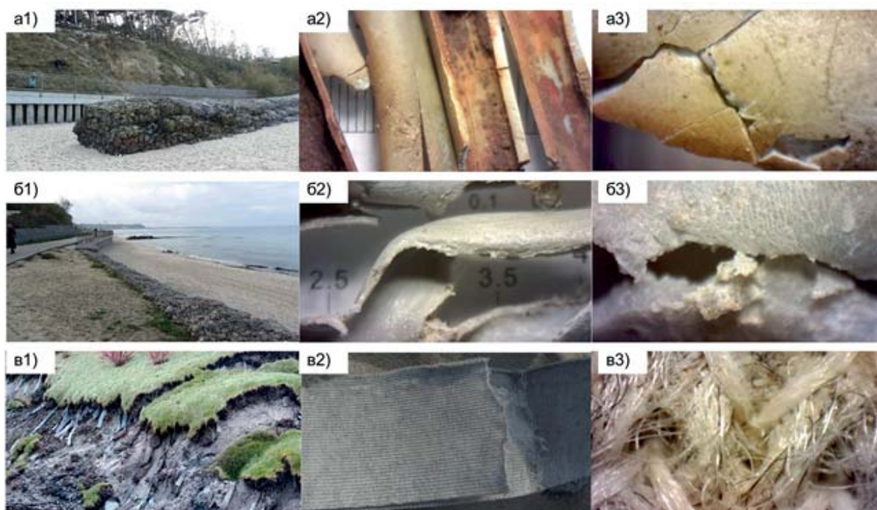
Рис. 5. Геосинтетические материалы на берегах у г. Пионерского: а1–а3 и б1–б3 — габионы с металлической сеткой, покрытой полимерным покрытием со следами деградации, на пляже и в основании склона, в1–в3 — деформированные геоячейки на размытом склоне. а3, б3, в3 — образцы при увеличении \times 40 (фото Есюковой Е. Е.).
