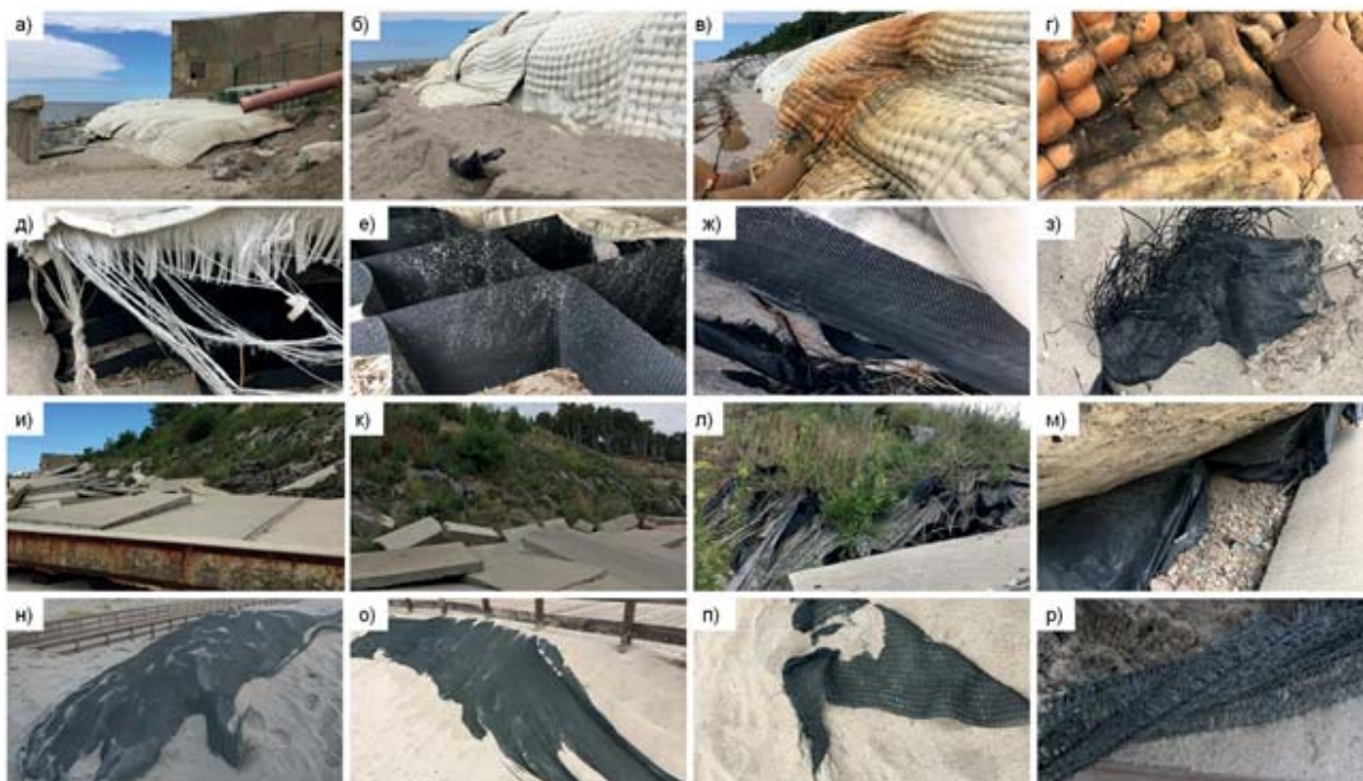
Рис. 3. Геосинтетические материалы на берегах у пос. Янтарный: а) защитные береговые сооружения у насосной станции Янтарного комбината, б–г) геотекстильные цементирующие оболочки (плиты) БетоБОКС со следами деградации, д–е) геоячейки под плитами БетоБОКС, ж) послойное расположение геоматериалов под плитами БетоБОКС, з) деформированный геоконтейнер, и–м) «Подпорная стенка с восстановлением берегового откоса» со следами деформации, н–р) геотекстильное полотно, фиксирующее песок у променада пос. Янтарный (фото Есюковой Е. Е.).
