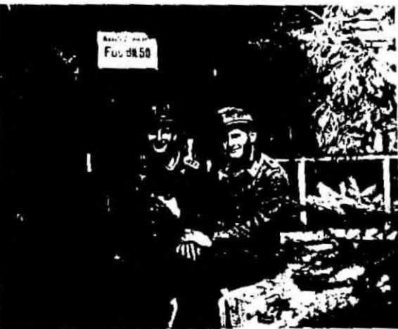
Bunker des Füs.Btl. 50 im Raum Goldap.
